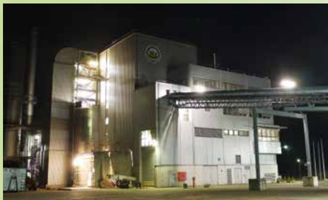
Impression bei Nacht: Das Biomasseheizkraftwerk Altenstadt.
